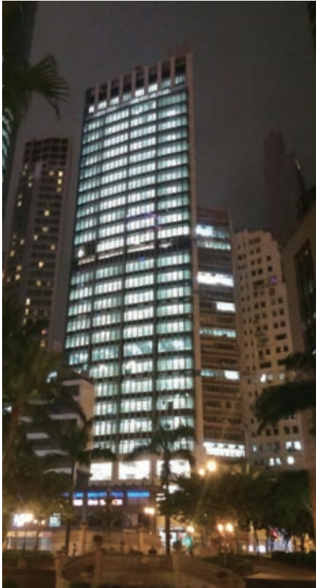
建業建築有限公司承建位於香港威靈頓街 184-198號之商業大廈
