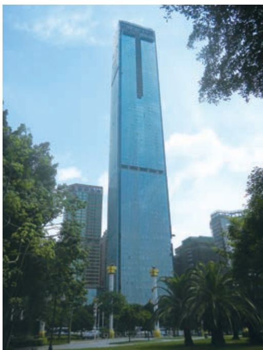
漢國城市商業中心—建築進行中
